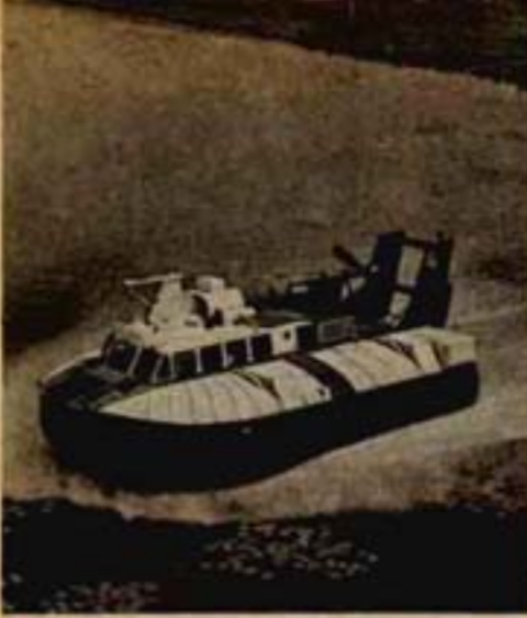
Niyagara Şelâlelerini besleyen Niyagara Irmağı üzerindeki küçük adalar arasında işleyen bir hava taşıtı. SK. 3 diye tanınan bu taşıt hem karada hem de suda aynı şekilde işlemektedir.
